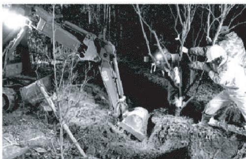
夜間にショベルカーを使って行われた樹木の移植作業
